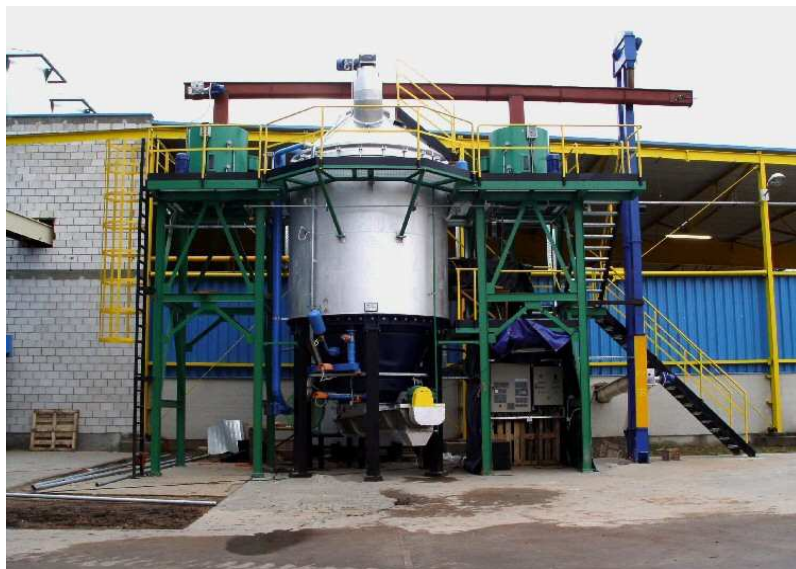
Komora zgazowania z systemem ciągłego załadunku paliwa.
